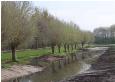
Abbildung 3: Fertiger Bauabschnitt II © Wasser- und Bodenverband der Mittleren Niers
