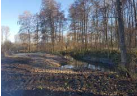
Abbildung 2: Bauabschnitt I, Mündungsbereich der Cloer in die Niers © Wasser- und Bodenverband der Mittleren Niers
